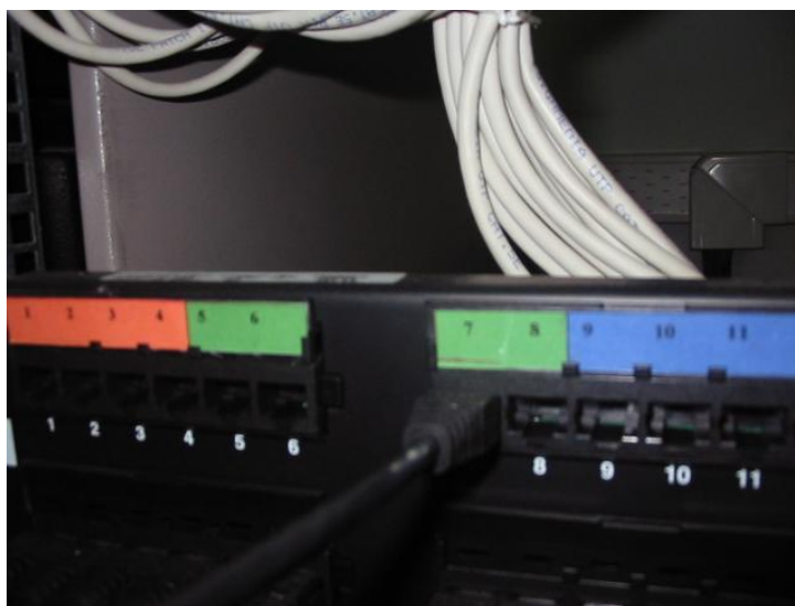
Figura 1.3: Cable derecho conectado al punto de red #7 del Patch Panel
